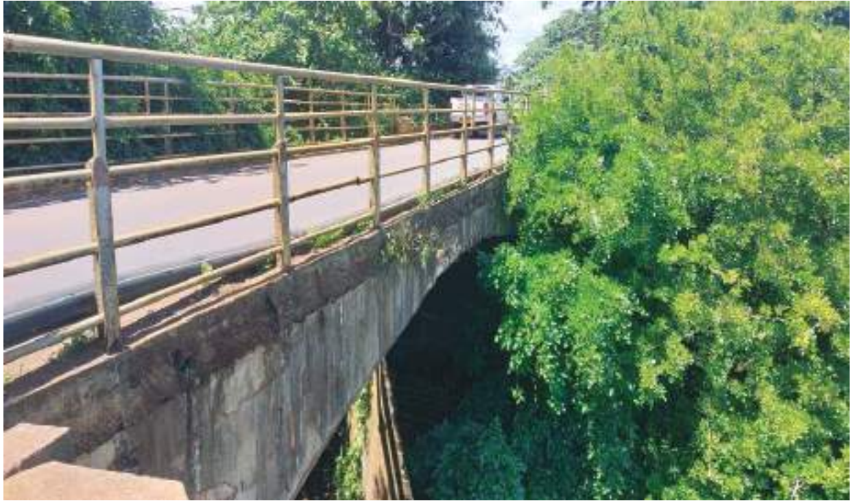
Figure 13: Reconstruction of Haute Rive Bridge at Rivière du Rempart
